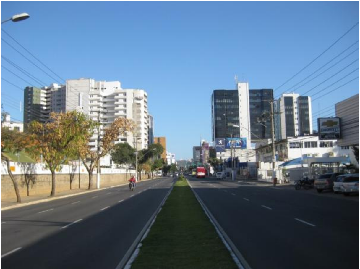
Figura 53 - Foto da Avenida Nossa Senhora da Penha localizada em Vitória - ES.
