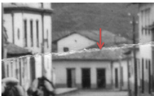
Figura 23: Vista da edificação de esquina a partir da Rua Dom Pedro II. Fonte: CDI, 2010
