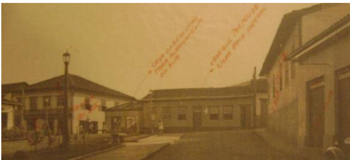
Figura 20: Imagem anterior ao alargamento da Rua Luiz Cassiano e a demolição da edificação de esquina.
