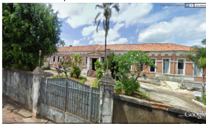
Figura 41: Fachada frontal do pavilhão de isolamento.
