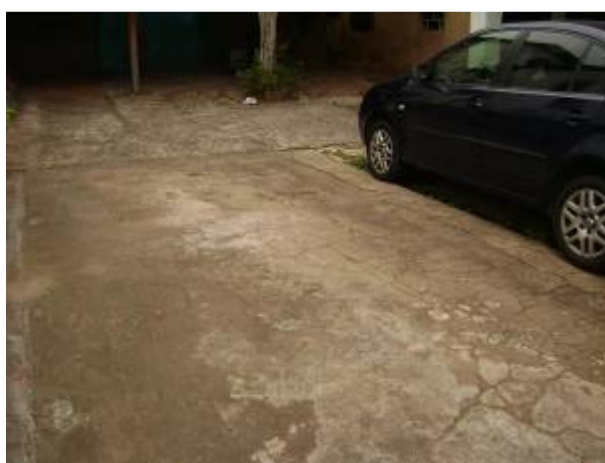
Figura 45: Parte interna da garagem com a marcação no piso da localização das paredes da lateral e dos fundos.
