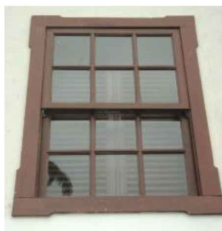
Figura 50: Detalhe das esquadrias utilizadas na nova edificação junto à Praça Mello Viana.
