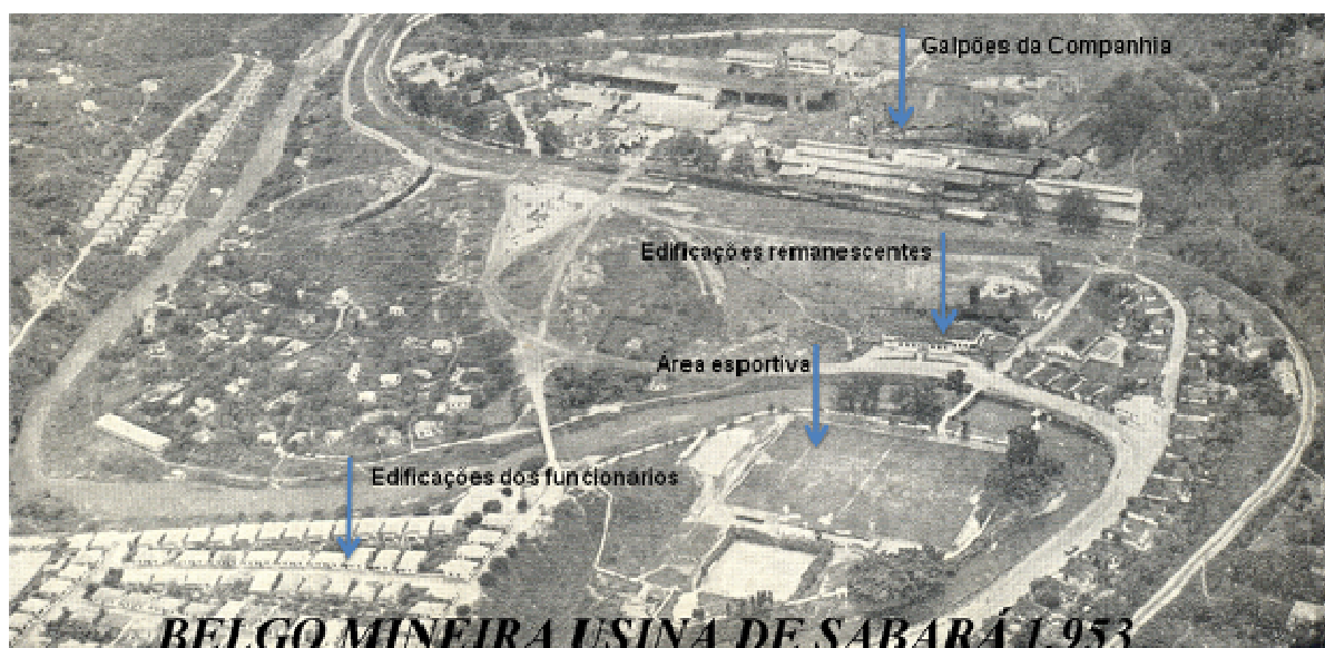
Figura 11: Vista aérea da área da Companhia Siderúrgica Mineira em 1953.
