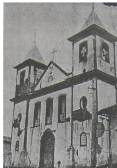
Figura 18: Fachada frontal Igreja de Santa Rita.
