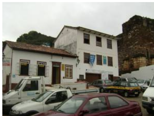
Figura 49: Nova edificação entre a edificação de um pavimento e a edificação tombada.
