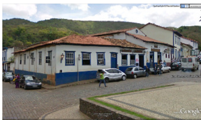
Figura 22: Vista para a nova fachada lateral da edificação vizinha à que foi demolida.
