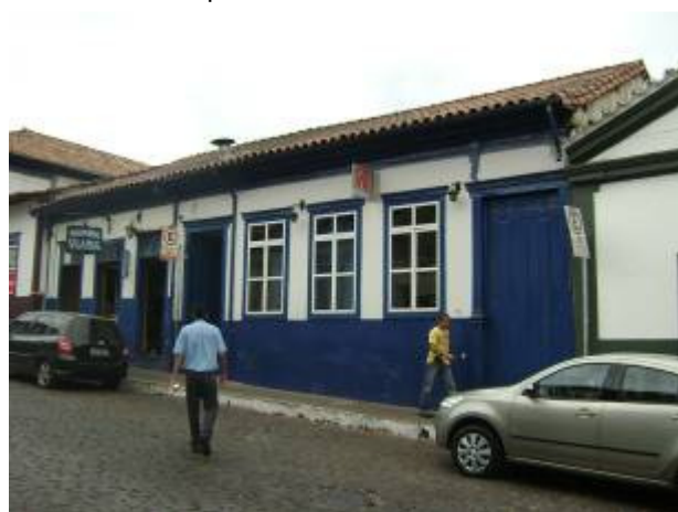
Figura 43: Fachada frontal da casa n° 312.
