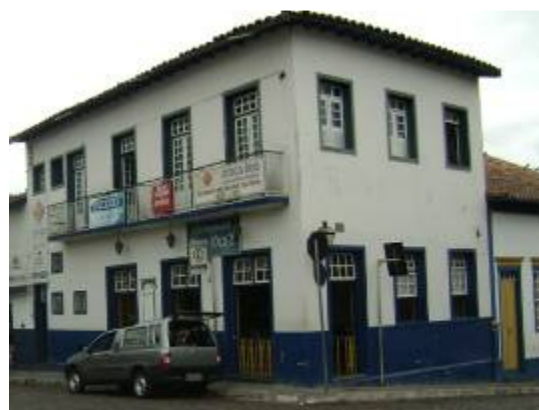
Figura 25: Vista para a edificação de esquina, agora com dois pavimentos.
