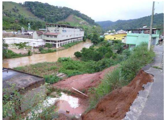
Figura 128: Obras em encosta à margem do rio causam erosão e, conseqüentemente, assoreamento. Data: jan. 2012.
