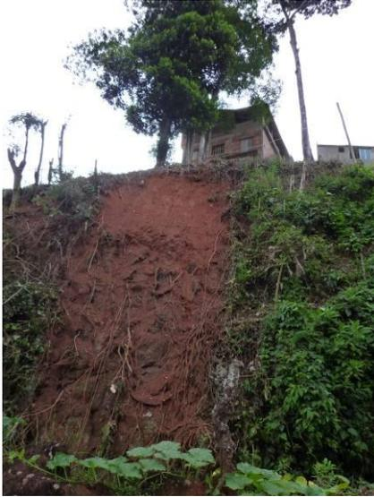
Figura 122: Desabamento de encosta com edificações sobre a ferrovia. Data: jan. 2012.
