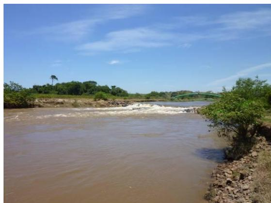
Figura 140: Barragem da CESAN no Rio Jucu para evitar que a água do mar penetre na captação. Data: fev. 2012.
