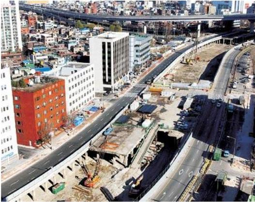
Figura 14: Obra de retirada das pistas e descobrimento do canal. Fonte: PETRESCU (2007).
