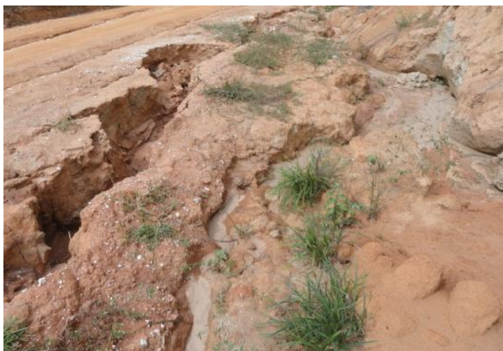
FOTOGRAFIA 2: Área marcada pela erosão e de difícil acesso à uma das comunidades rurais do Município de Jerônimo Monteiro.
