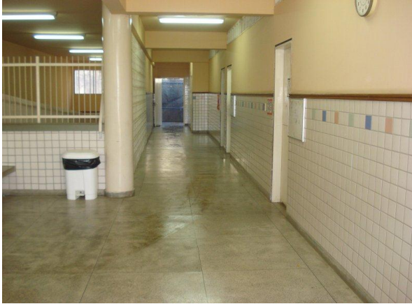
Foto 5 - Corredor e salas de aula do Grupo V. No final do corredor, há outra rampa que dará para a quadra de esportes coberta.
