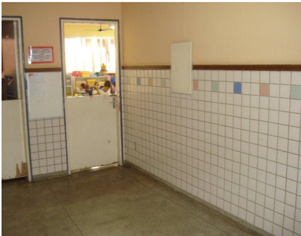
Foto 7 - Entrada da sala de aula do 1º ano, localizada à esquerda do corredor da Foto 6.
