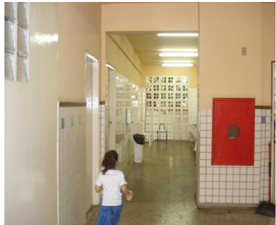
Foto 8 - Corredor que dá acesso aos banheiros, ao bebedouro e ao lavabo.
