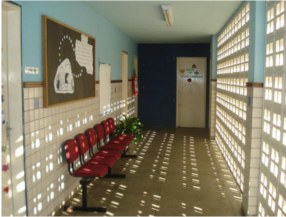
Foto 1 - Corredor onde fica a secretaria da escola, a sala da diretora e a sala dos professores.
