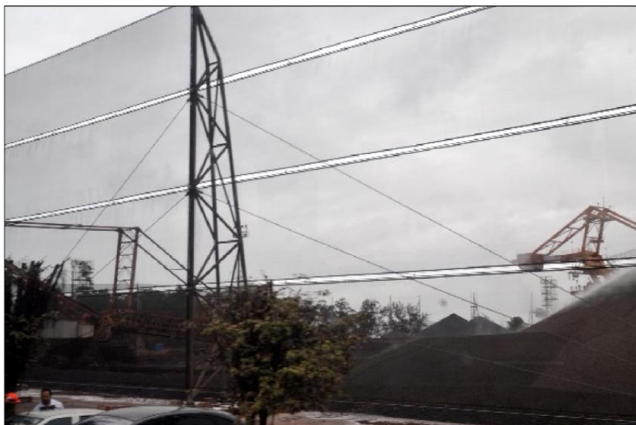
Figura 4 - Primeira Wind Fence implantada pela Vale em atendimento ao Termo de Compromisso Ambiental assinado junto ao Ministério Público. Fonte: Espírito Santo (2009)
