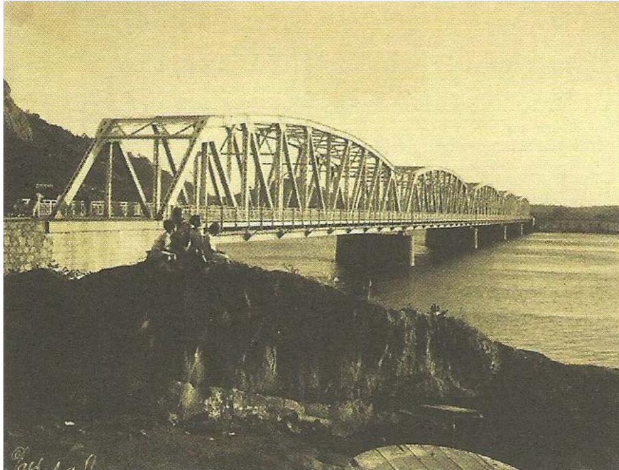
Figura 19 - Ponte Florentino Avidos. Fonte: Klug (2009)
