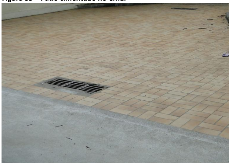
Figura 35 – Pátio cimentado no CMEI
