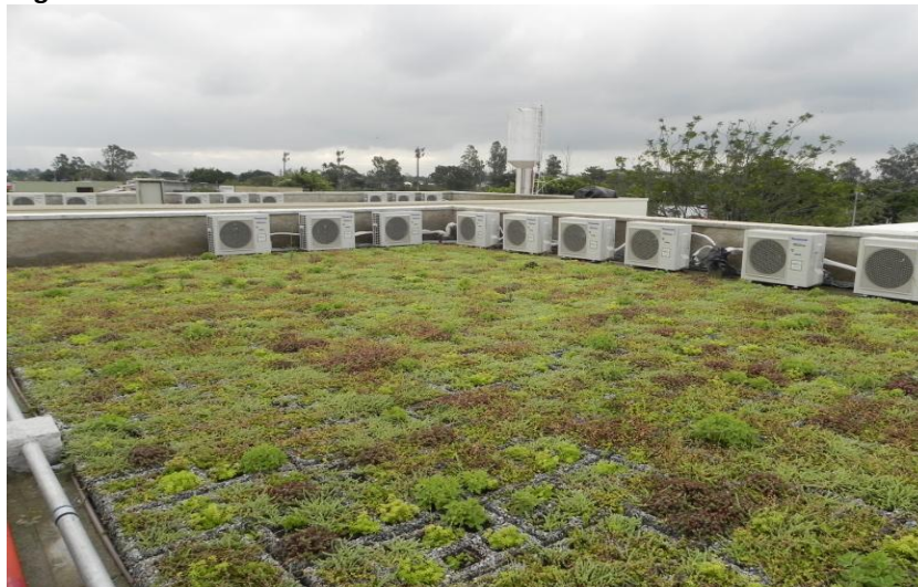
Figura 19 – Telhado verde da Escola Catavento do Rio de Janeiro
