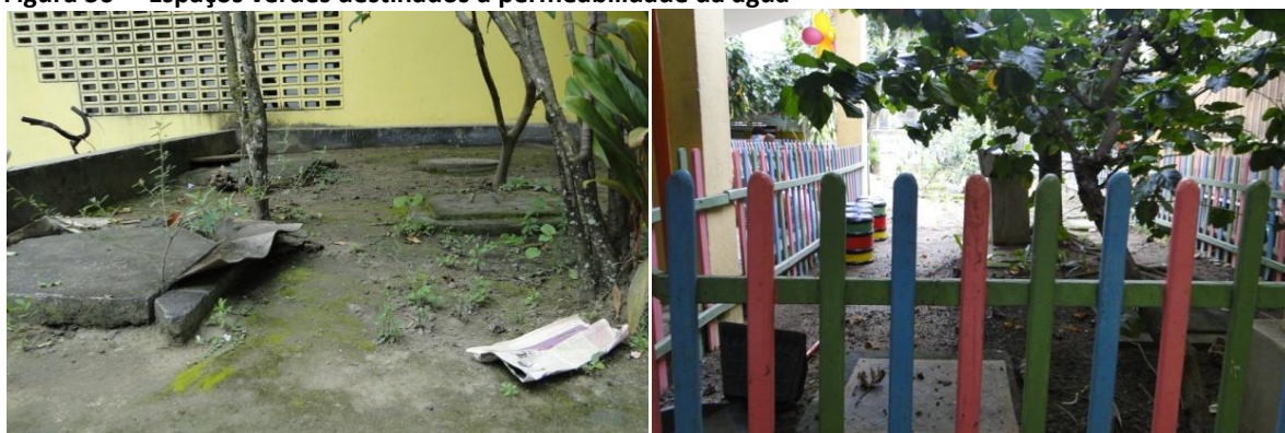
Figura 36 – Espaços verdes destinados à permeabilidade da água
