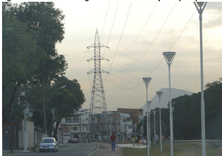
Figura 28 – Torre de energia elétrica sobre o calçadão para pedestres
