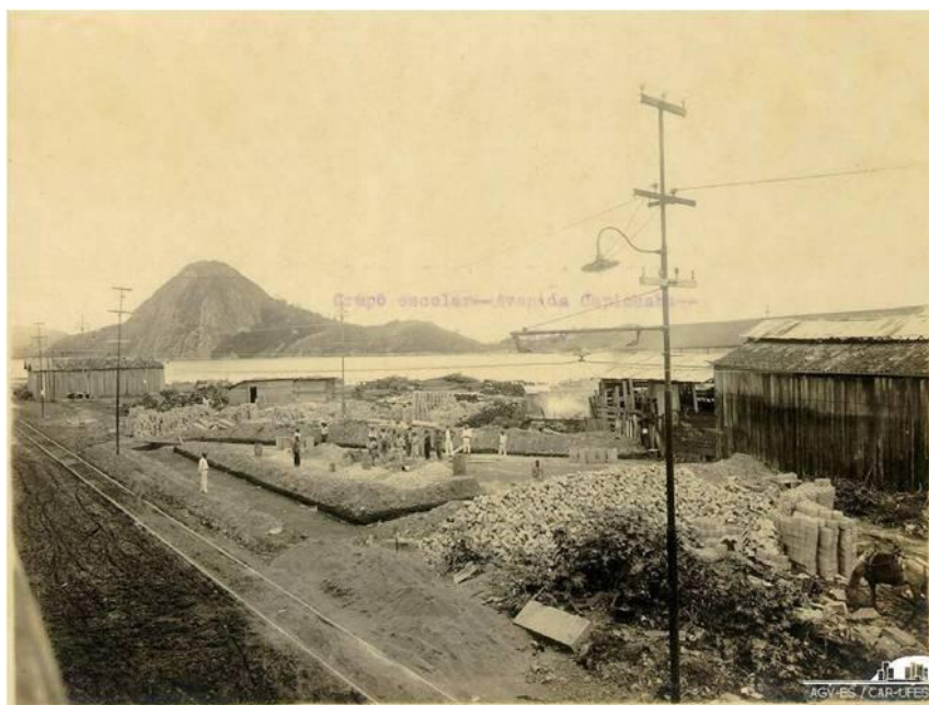
Figura 19 – Construção do Grupo Escolar Gomes Cardim na Avenida Capixaba.
