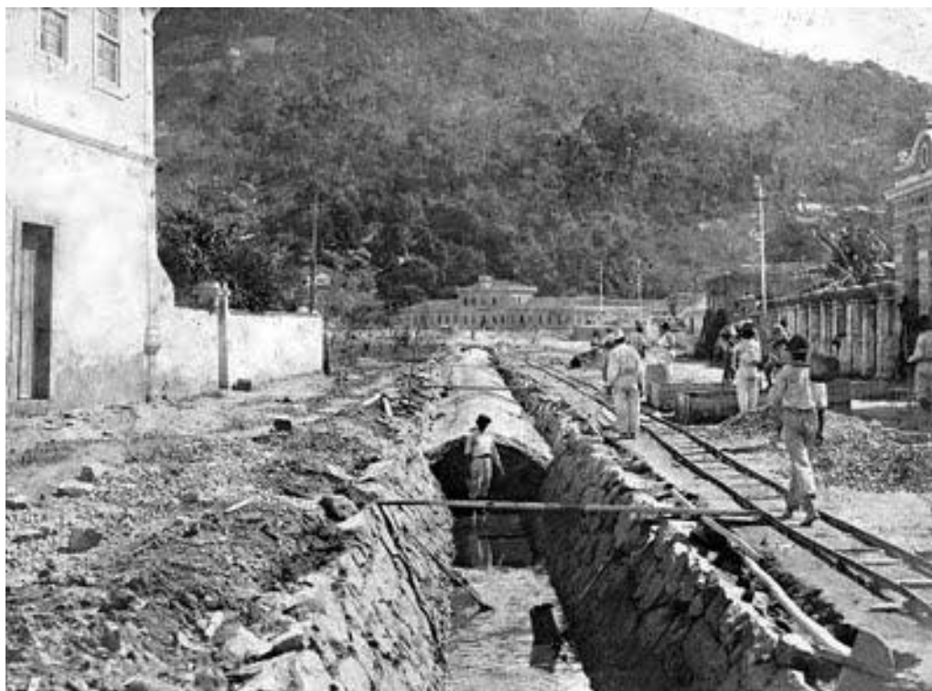
Figura 1 – Obra de canalização do curso de água na atual Avenida República.
