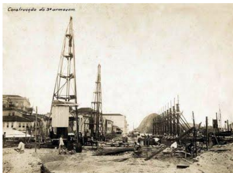
Figura 3 – Construção dos armazéns do Porto de Vitória. Obra de canalização do curso de água na atual Avenida República.
