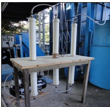
Figura 5.5 - Filtros depuradores de biogás
