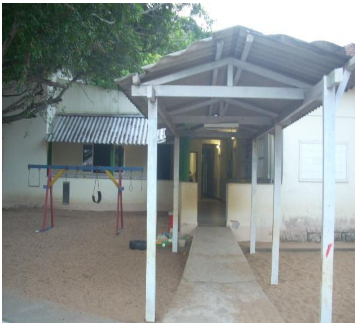
Foto 3 _ Fachada da escola
