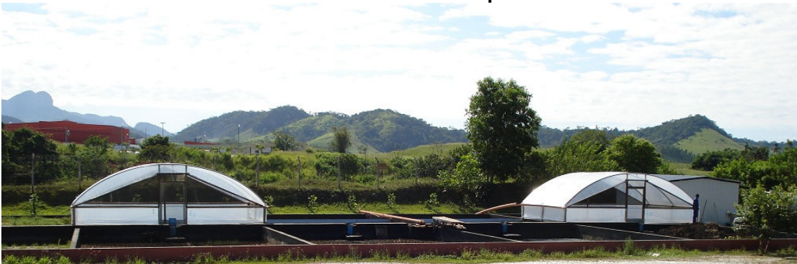
Figura 8 - Vista panorâmica dos quatro leitos de secagem e dos módulos de estufa instalados nos leitos das extremidades direita e esquerda
