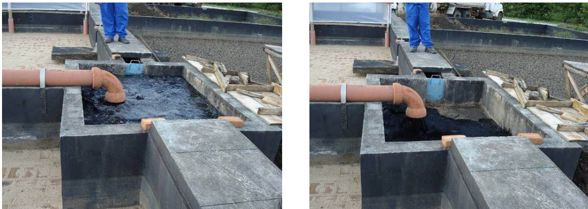
Figura 7 - Ponto de distribuição no momento da medição de vazão
