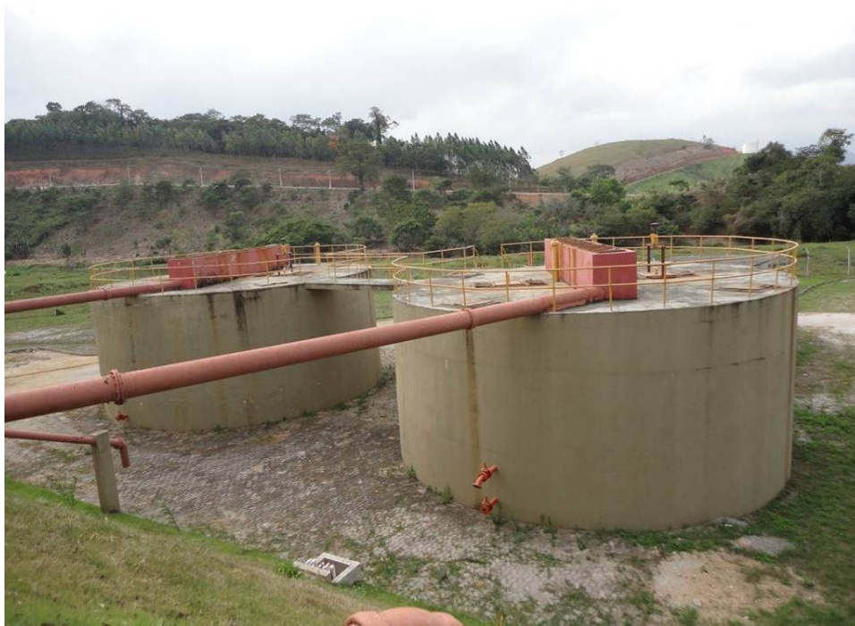
Figura 5 - Vista dos reatores UASB – ETE Castelo
