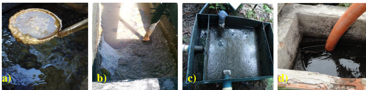
Figura 1. Escuma da caixa de gordura Industrial (a); Escuma da Caixa de Gordura do Restaurante Universitário (b); Escuma da Caixa de Gordura da ETE (c); Coleta sendo realizada de Lodo de Tanque Séptico com auxílio de caminhão limpa-fossa (d).
