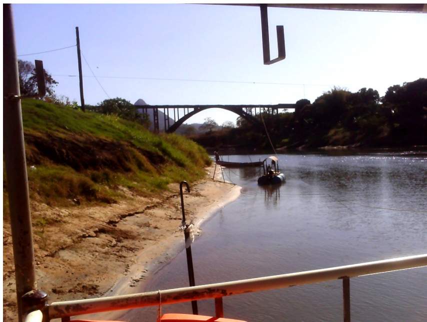
Foto 1. Ponte de Itapina que não foi finalizada desde a década de 50 do século passado.
