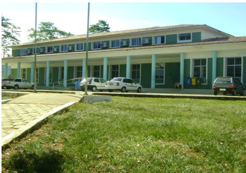
Foto 2. Entrada do prédio administrativo e das salas de aulas do Ifes Campus Itapina.
