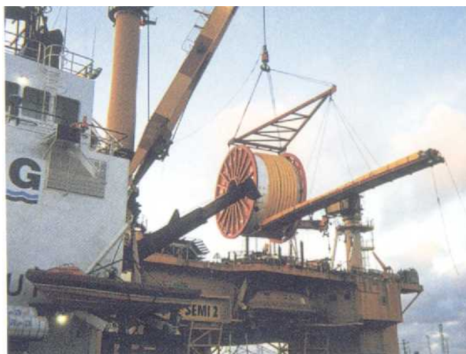
Figura 1.18 – Navio transportando tubo flexível em carretel para instalação.
