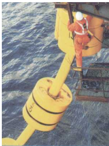
Figura 1.19 – Lançamento de um tubo flexível no mar. As conexões já entram na água devidamente prontas.
