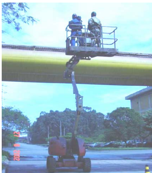
Figura 27 - Fotografia mostrando a realização da termovisão
