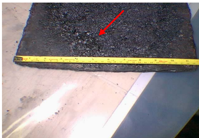
Figura 60 – Amostra de tubulação de COG removida da área de Utilidades, pode-se verificar a existência de uma grossa e aderida camada de alcatrão sobre a superfície do tubo
