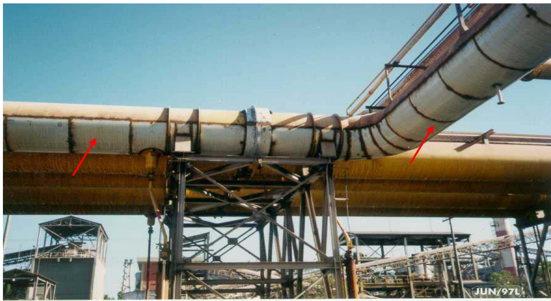
Figura 58 - Tubulação de COG da área de Utilidades, reforçada com chapa no hemisfério inferior em função da corrosão acentuada
