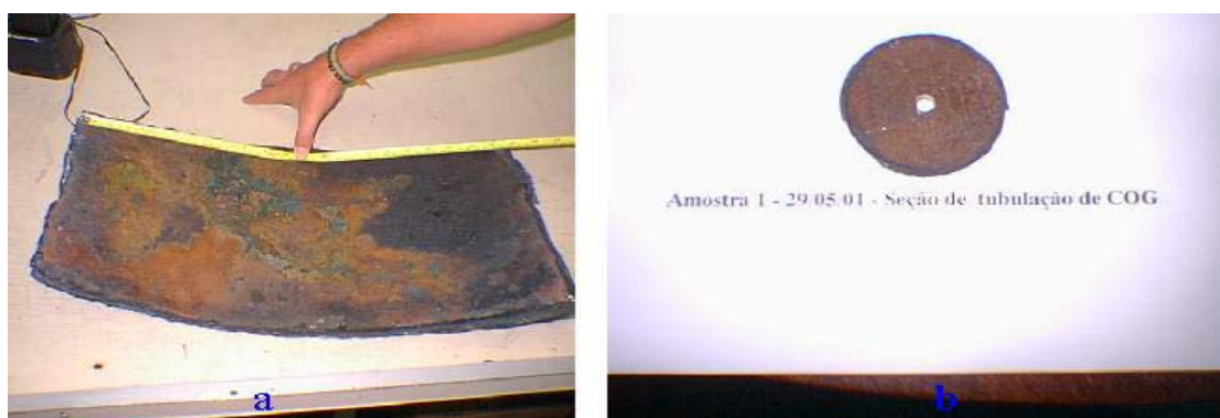
Figura 47 – (a) Peça do fundo da tubulação de COG (dezoito anos de operação). (b) Amostra removida do pedaço da figura (a), para análise no MEV
