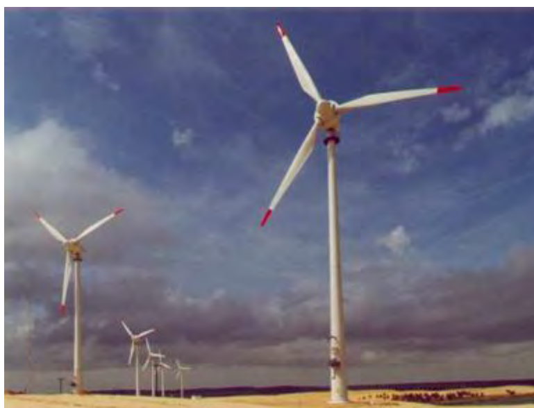
Figura 2.10 - Parque eólico conectado à rede (Fonte: CRESESB, 2014)
