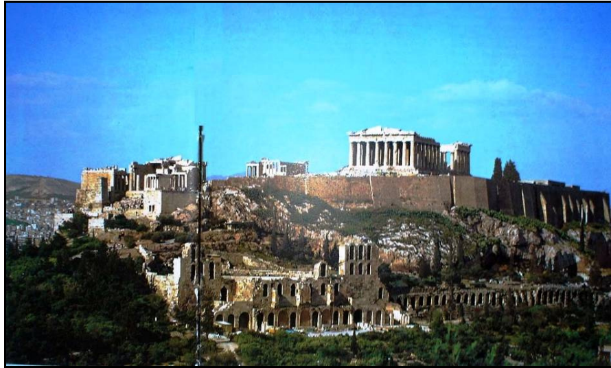
Fig. 5. Vista da Acrópole de Atenas. Construções que reúnem as qualidades do lugar. Fonte: GOITIA, 1995, p. 58.
