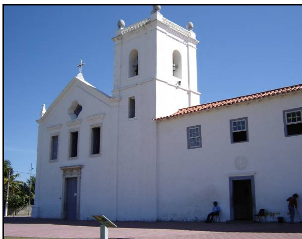
Fig. 31. Fachada principal da Igreja e Residência de Reis Magos. Fonte: Foto da autora.
