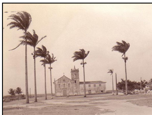
Fig. 22. Vista da fachada principal da Igreja e Residência de Reis Magos e a praça fronteiriça, provavelmente na década de 1970. Fonte: INSTITUTO JONES DOS SANTOS NEVES, s.d.
