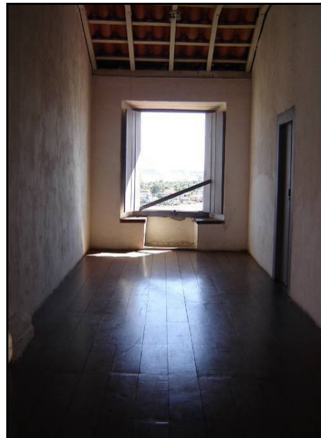
Fig. 44. “Conversadeira” também da fachada posterior da edificação, com dois assentos. Fonte: Foto da autora.
