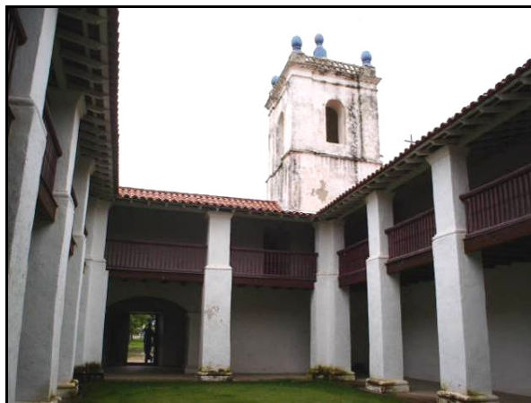
Fig. 28. Torre sineira vista da varanda do pavimento inferior. Fonte: Foto da autora.
