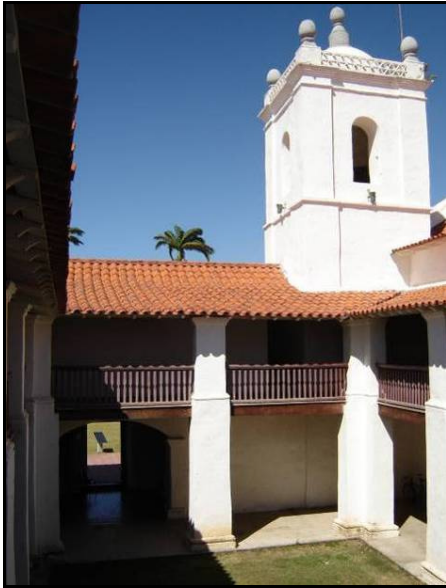
Fig. 48. Vista do pátio interno a partir da varanda superior, em direção à entrada principal da residência. Acima, a torre sineira. Fonte: Foto da autora.
