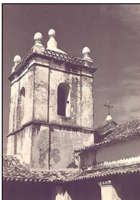
Fig. 29. Foto de Isauro Rodrigues da torre sineira da Igreja e Residência de Reis Magos, vista a partir da varanda do pavimento superior da edificação. Fonte: http://www.estacaocapixaba.com.br/texto/texto.php .
