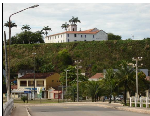
Fig. 59. A igreja vista a partir da Ponte Nova. Fonte: Foto da autora.
