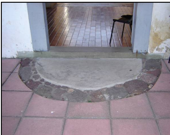
Fig. 35. Detalhe da soleira da porta de entrada da residência. Fonte: Foto da autora.
