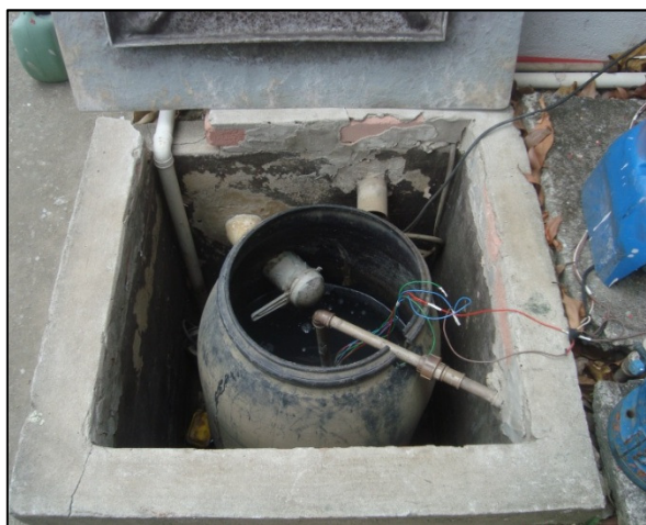
Figura 18. Reservatório de água cinza bruta.
