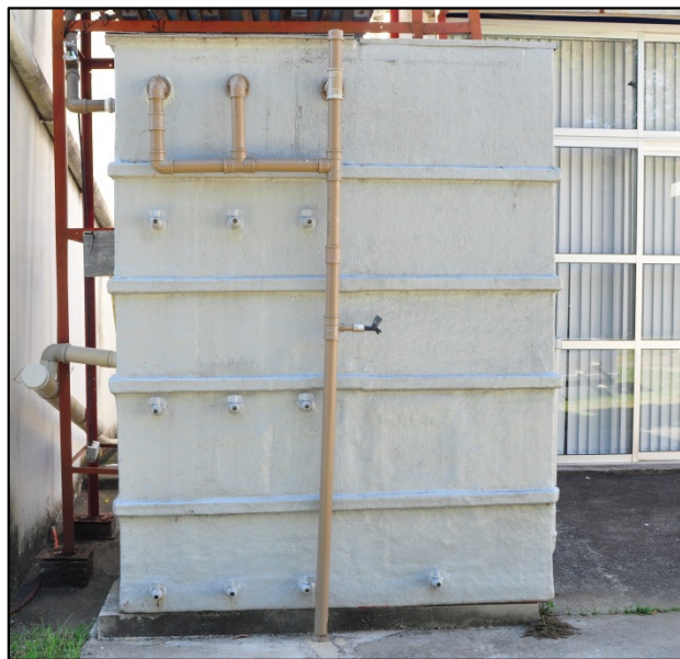
Figura 13. Filtro anaeróbio de fluxo ascendente.
