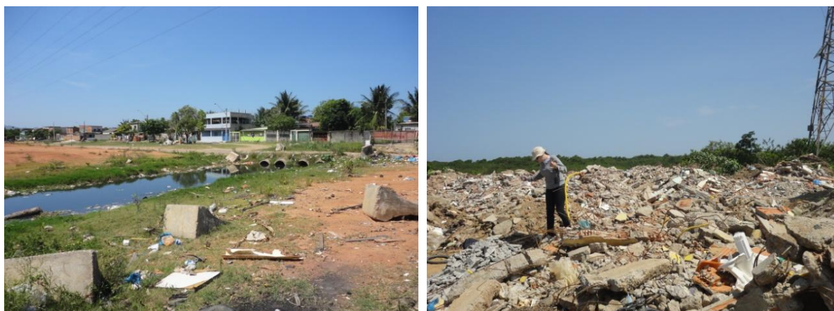
Figura 7 – Impactos ambientais observados no Ponto 1 – valão e depósito de entulho
