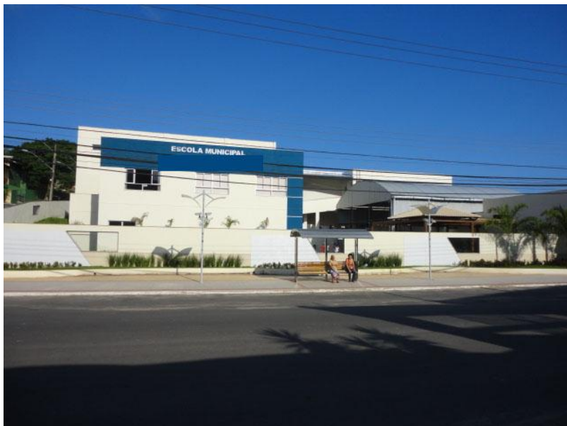
Fotografia 1 – Fachada da EMEIEF campo da pesquisa. Fonte: arquivo pessoal da pesquisadora.
