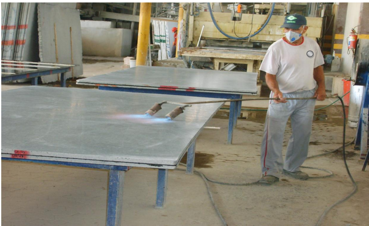
Figura 11: Aquecimento das chapas uma a uma com maçarico para retirada de umidade.
