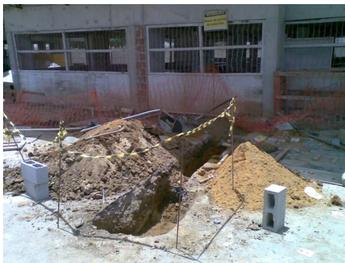
Fotografia 4.10 – Reforma da rede hidráulica da empresa C remove bebedouro.
