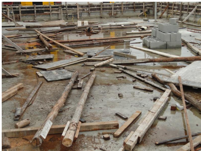
Fotografia 4.15 – Laje superior da obra da empresa D.
