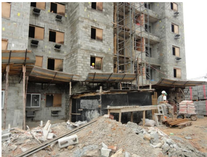
Fotografia 4.14 – Entrada de um edifício da obra da empresa B.
