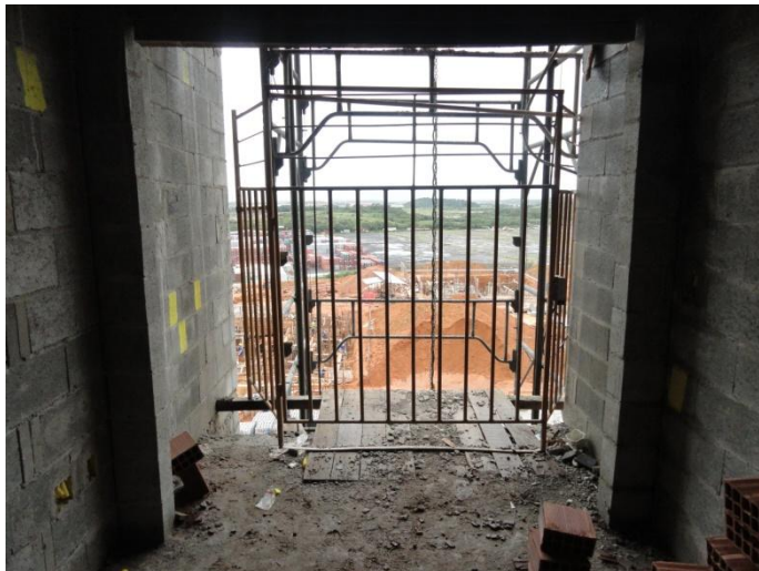
Fotografia 4.16 – Rampa de acesso à torre do elevador da obra da empresa B.
