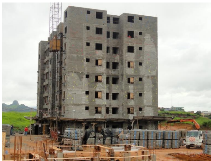
Fotografia 4.27 – Pátio de materiais da obra da empresa D.
