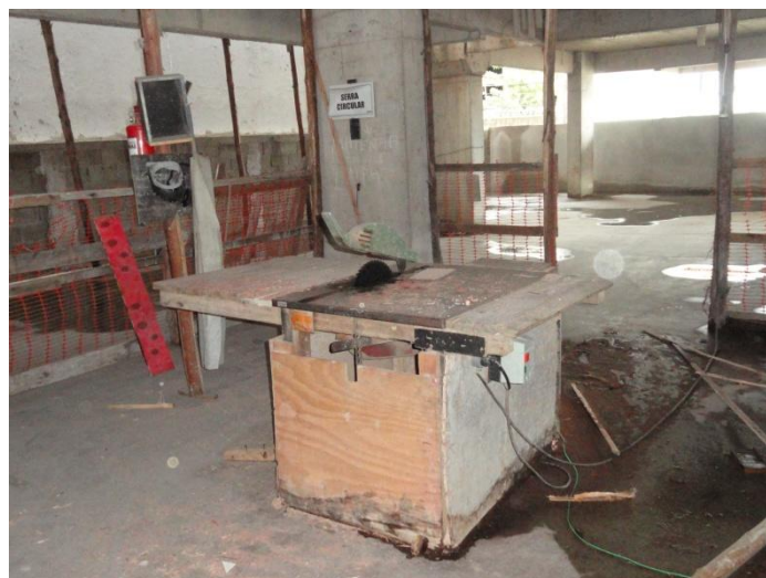
Fotografia 4.24 – Carpintaria da obra da empresa D.
