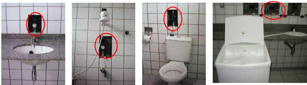
**Figura 4-26:** Hidrômetros instalados no lavatório, chuveiro, vaso sanitário
