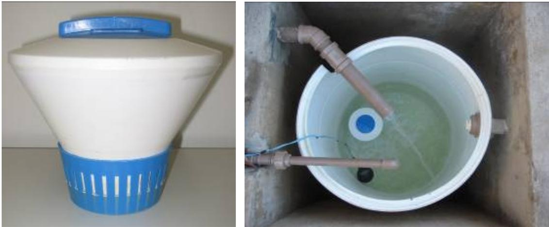
**Figura 4-18:** Flutuador utilizado na desinfecção
