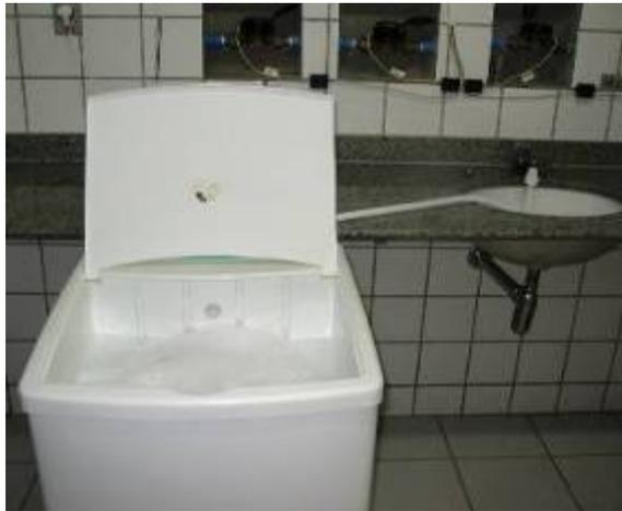
**Figura 4-19:** Máquina de lavar acoplada ao lavatório
