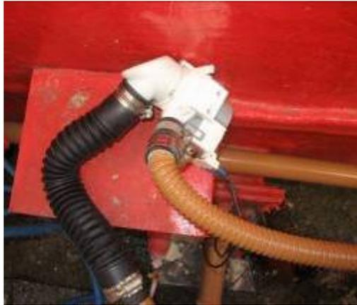
Figura 4-16: Bomba utilizada no descarte do lodo aeróbio
