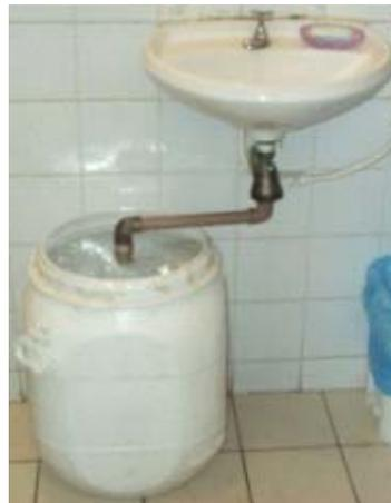
Figura 4-1: Coleta da amostra do lavatório
