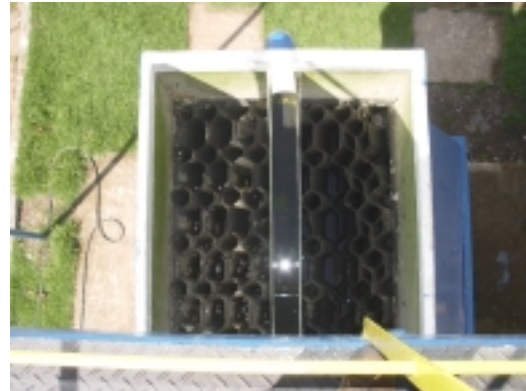
Figura 4.3: Vista aérea do decantador
