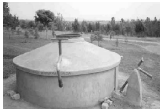
Figura 20 – Reservatório em ferro-cimento
