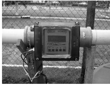
Figura 30 – Medidor de Vazão
