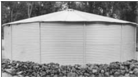
Figura 21 – Reservatório de aço
