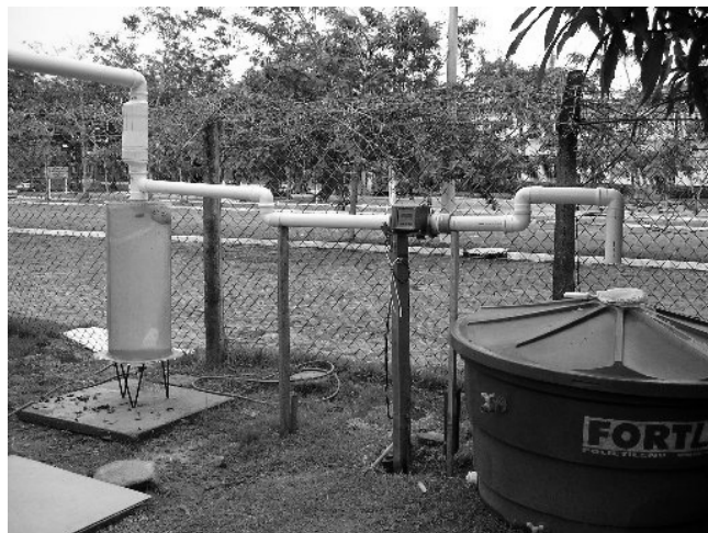
Figura 33 – Vista Geral do Sistema
