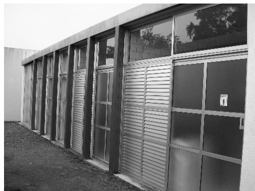
Figura 25 – Prédio com rede dupla de água do Parque Experimental do Núcleo Água
