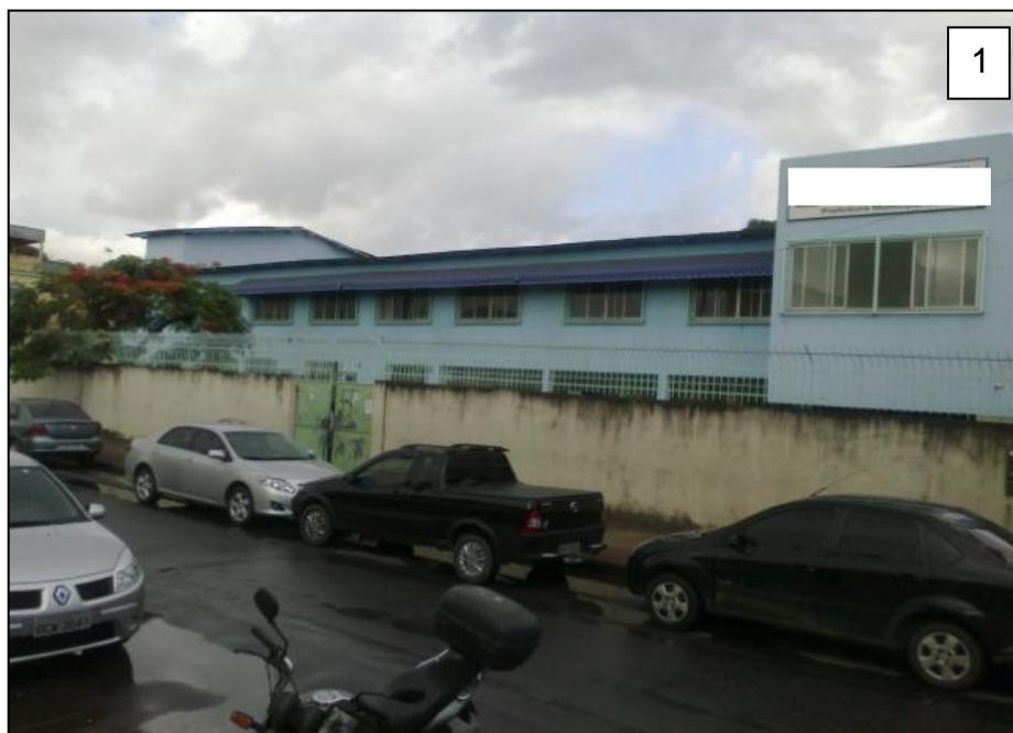
Foto 1 - Fachada e vista de fora da escola A
