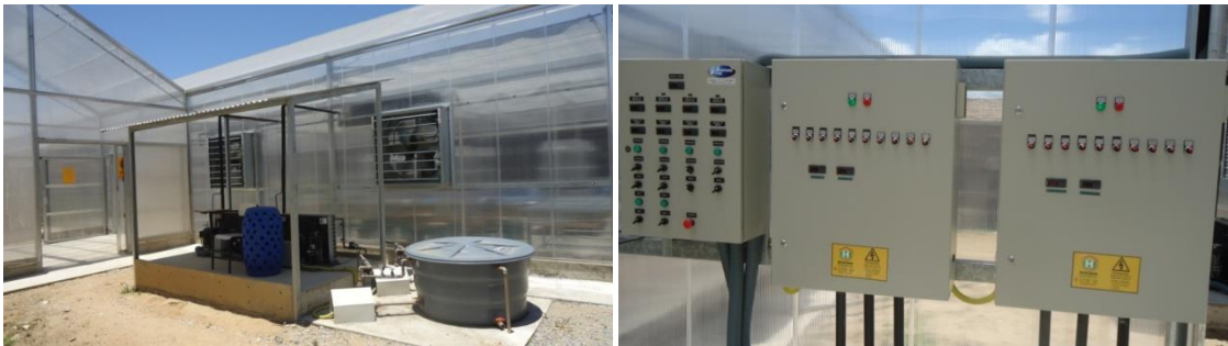
Figura 11 – Parte externa e painel de controle das variáveis climáticas da casa de vegetação climatizada, do Departamento de Ciências Florestais e da Madeira da Universidade Federal do Espírito Santo, em Jerônimo Monteiro ES.
