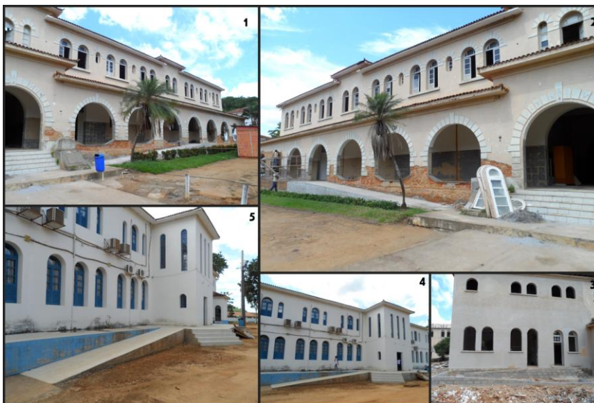
Foto 21: Prédios com rampa e reforma com adaptação no campus Santa Teresa 12 .
