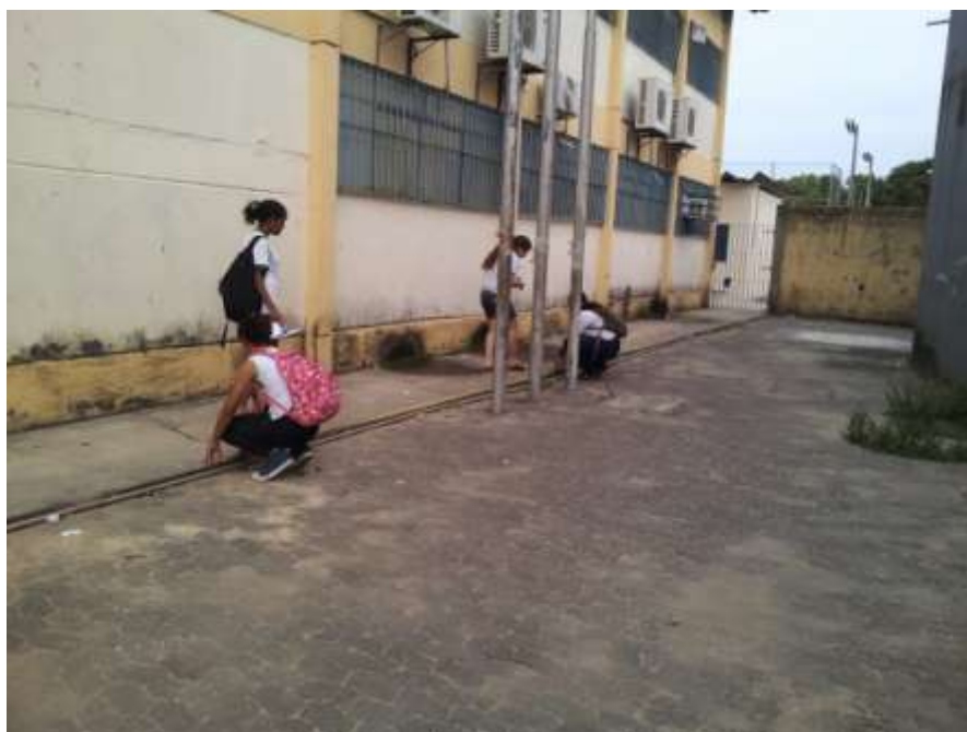
Figura 11. Parede com colunas externas (25/09/2012).
