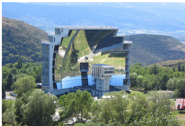
Figura 8 – Forno solar em Odeillo, que atinge até 3800^{\circ}\text{C} . Autor: Björn Appel. Licença de uso: http://creativecommons.org/licenses/by-sa/2.5/
