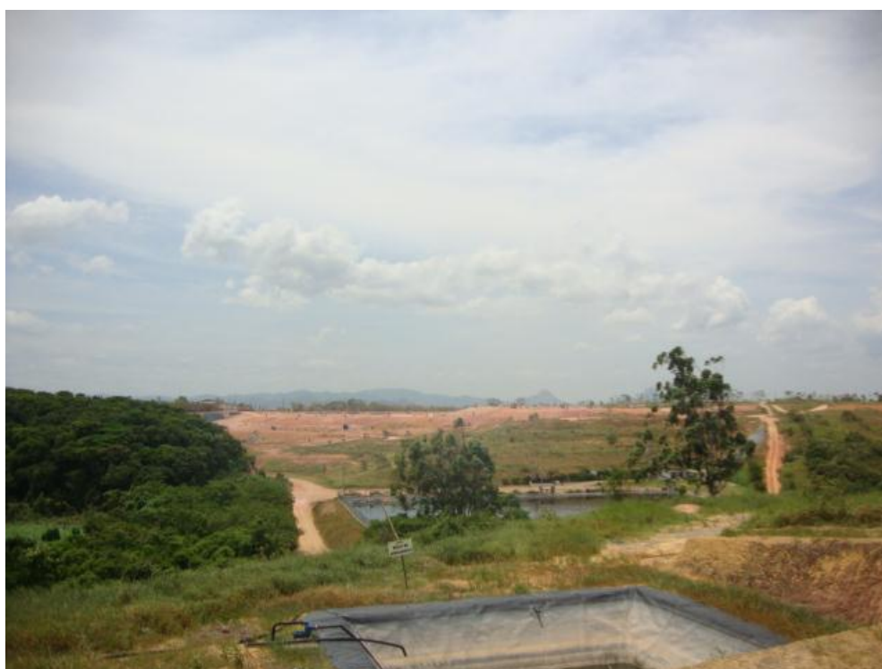
Vista parcial do aterro e do sistema de tratamento de chorume da Empresa CTRVV.
