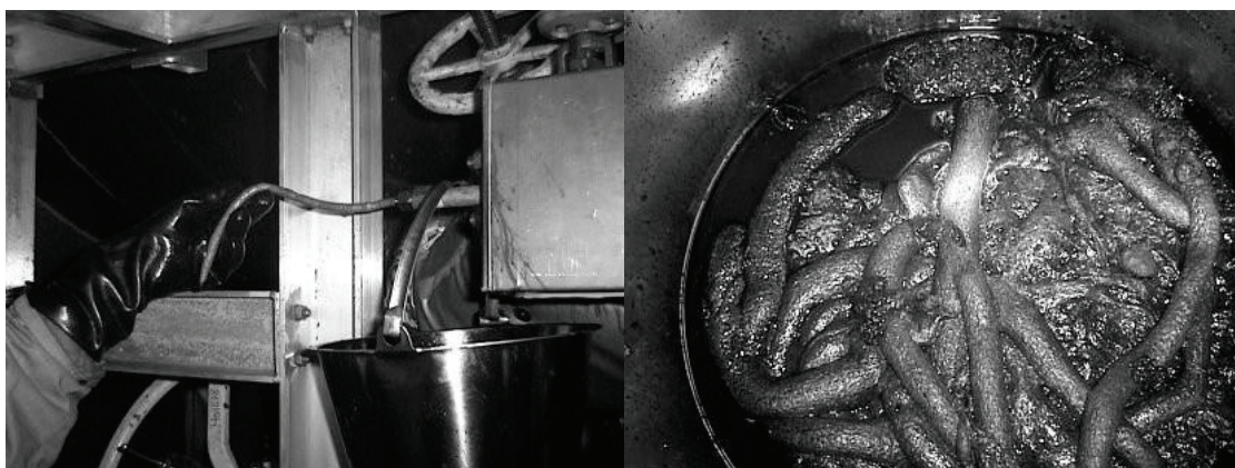
Figura 20. Saída o separador (figura da esquerda). Depósito de naftenato de cálcio em um separador óleo/água (imagem da direita).
