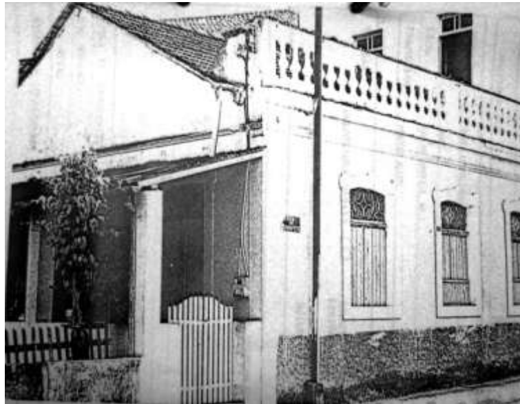
Figura 27 – Fachada do imóvel 2 na década de 1980
