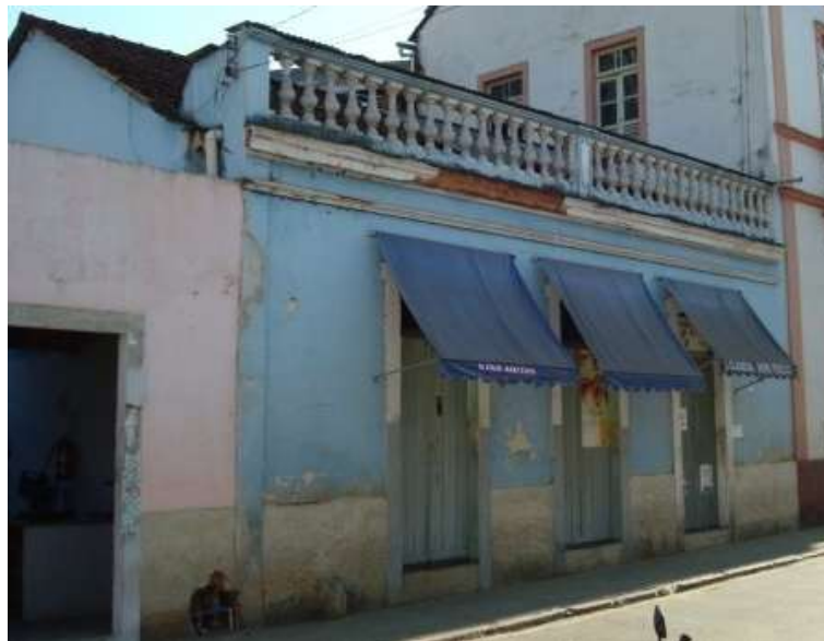
Figura 28 – Fachada do imóvel 2 em 2008
