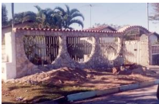
Figura 71 - Construção de muro casa C2 Fonte: Cedoc Fibria
