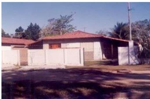
Figura 63 - Muro e mudança de fachada casa B3 Fonte: Cedoc Fibria
