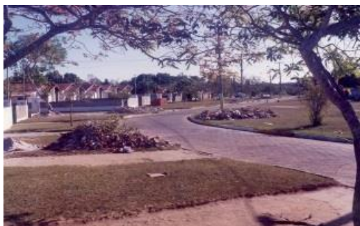
Figura 65 - Rua dos Ipês e entulho decorrente das obras Fonte: Cedoc Fibria
