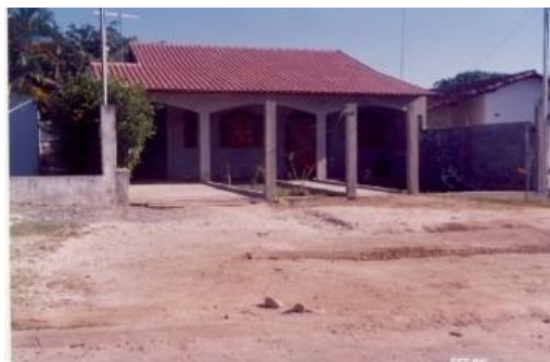
Figura 70 - Mudança no telhado e fachada casa C2 Fonte: Cedoc Fibria
