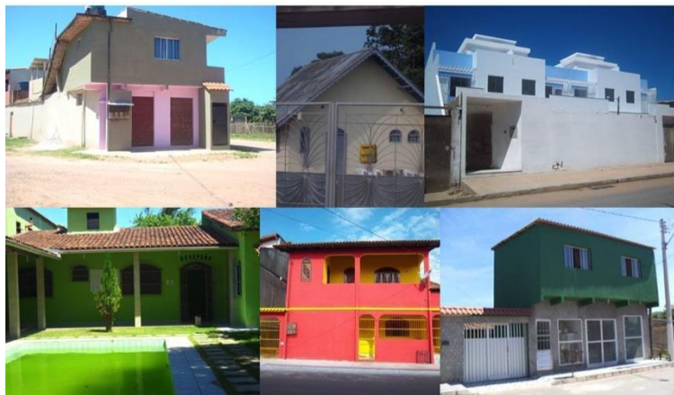
Figura 12 – Montagem de fotografias das construções.
