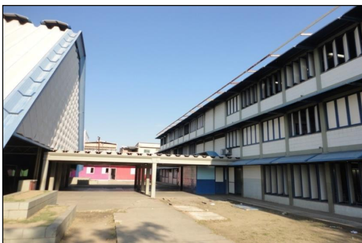
Fotografia 2- Visão da parte de trás da Escola e das salas anexas.
