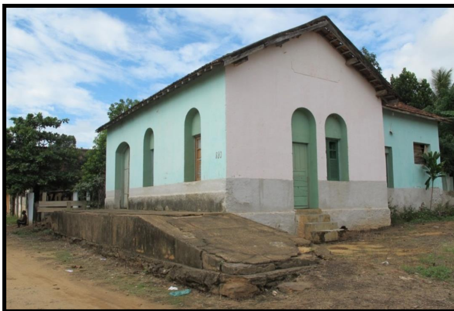
Figura 26: Antiga estação de Pedra Corrida - MG, 2013. Fonte: Tamara Lopes Teixeira.
