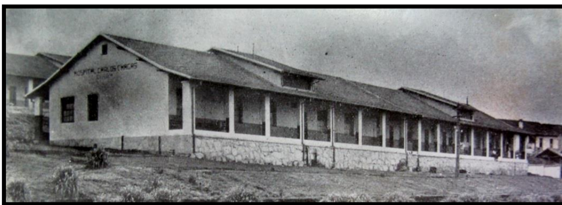
Figura 41: Hospital de emergência para os empregados da CVRD, em Itabira - MG, s/d. Fonte: Arquivo particular de Mário Carvalho Neto.
