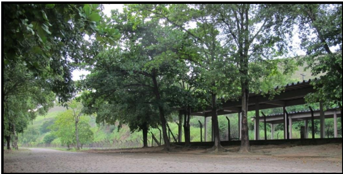
Figura 07: Atual estação de Colatina - ES. À direita a ferrovia e estação, 2013. Fonte: Tamara Lopes Teixeira.
