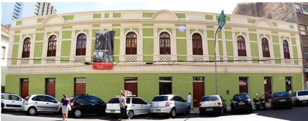
Imagem 01 – Museu Capixaba do Negro (MUCANE), após obras realizadas pela Prefeitura de Vitória. Fonte: Na Grande Vitória. Fotos Panorâmicas (2013?).
