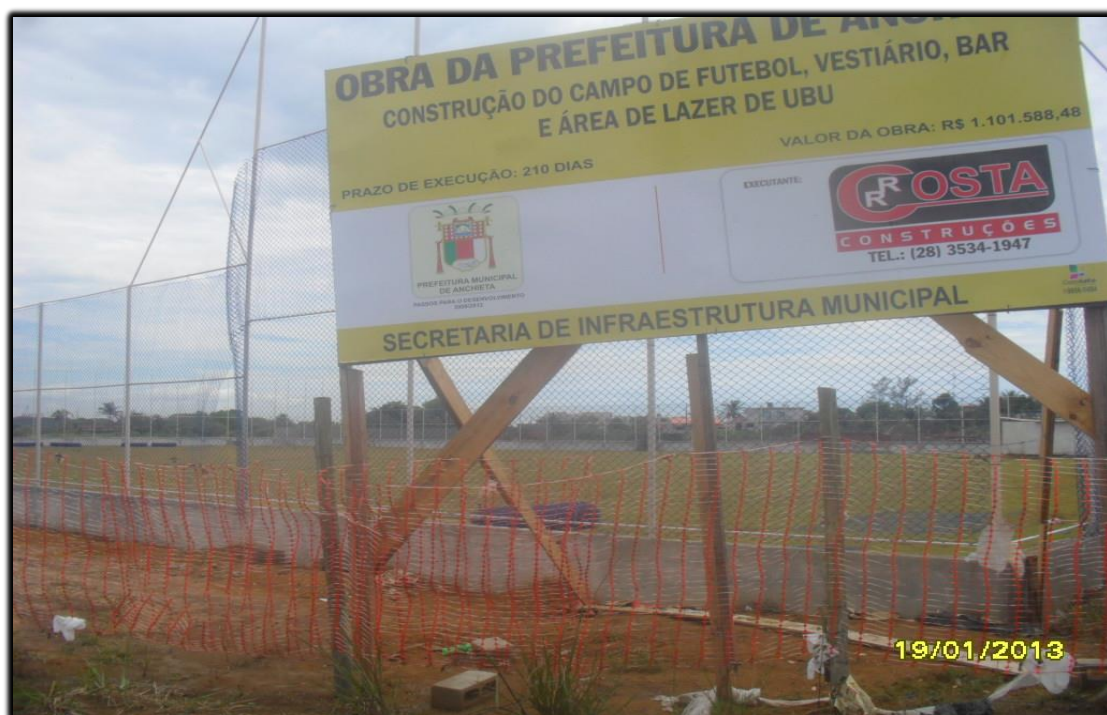
Foto 37 – Campo de Futebol em Ubu em obras.
