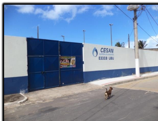
Foto 22 – Estação de abastecimento de água da CESAN em Ubu. Fonte: Josilene Corrêa (maio de 2012)
