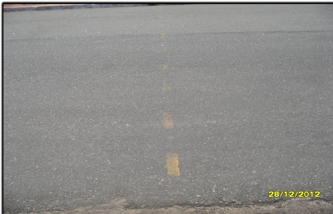
Foto 52 – Marcações no asfalto realizada pela empresa Petrobras indicando lugar onde se pretende construir terminal portuário.
