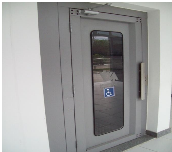
Figura 2 – Elevador acessível (Prédio CCJE)
