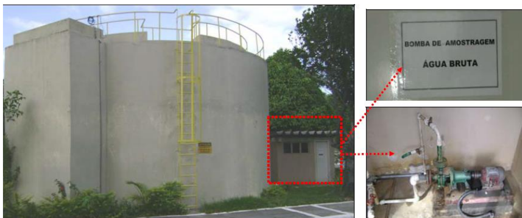
Figura 7 - Tanque de chegada da água bruta e bomba de amostragem.
