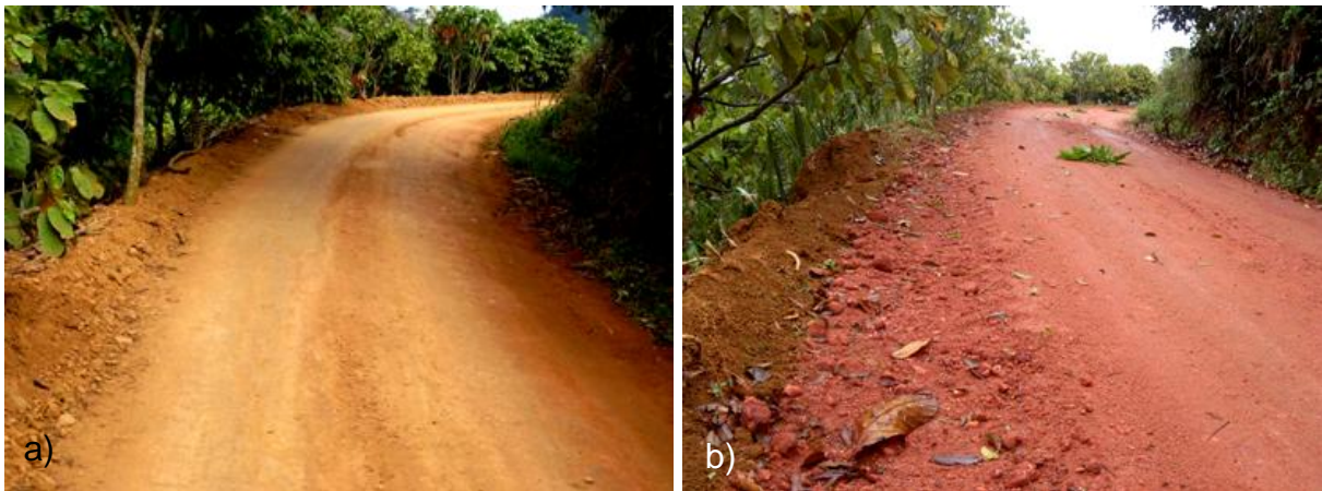
Figura 36 – Trecho de maior uso antes (a) e após (b) a manutenção.
