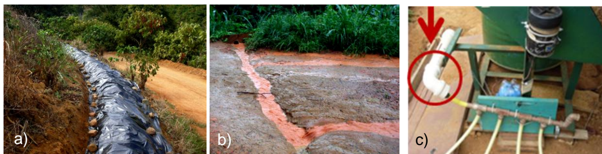
Figura 70 – valas de proteção (a), valetas de captação de fluxo (b) e alteração no tubo coletor (c).
