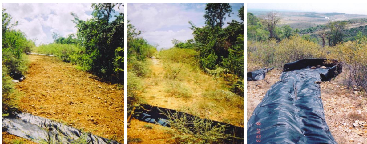
Figura 7 – Retenção de sedimentos em filtros de tecido. Fonte: Ramos-Scharrón (2010)
