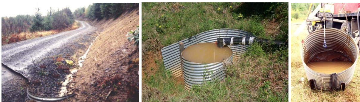
Figura 5 – Retenção de sedimentos em tanques. Fonte: Black e Luce (2007)
