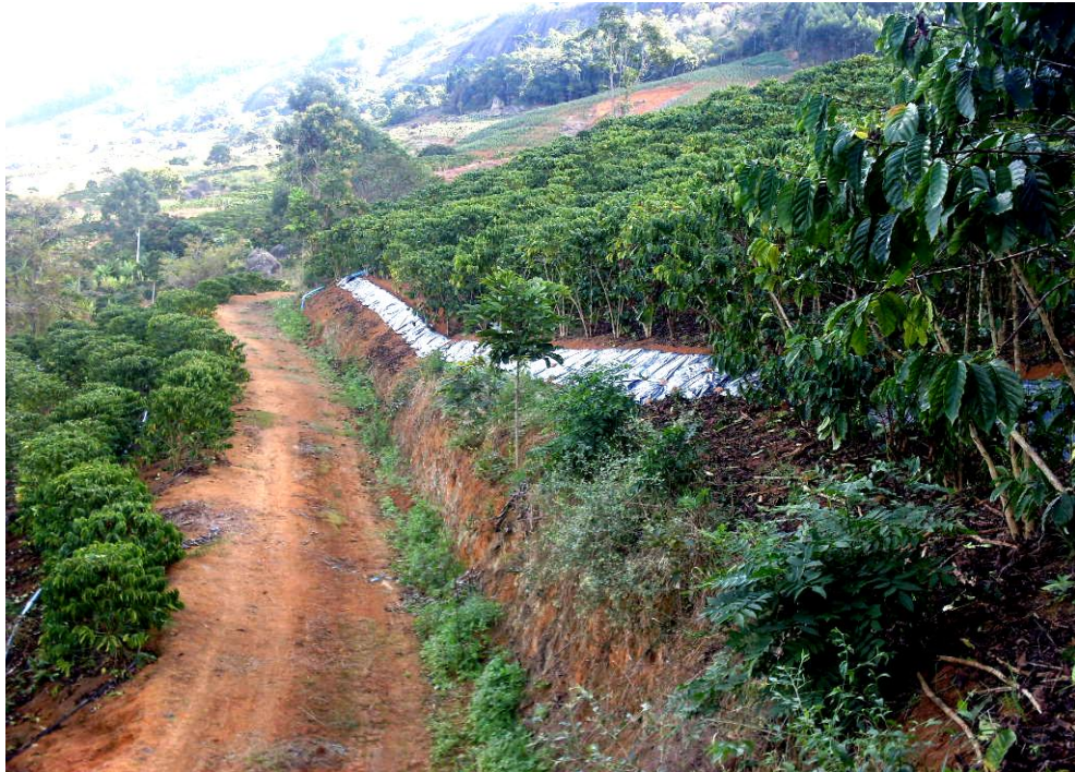
Figura 22 – Valetas de proteção acima dos taludes no trecho de menor uso.
