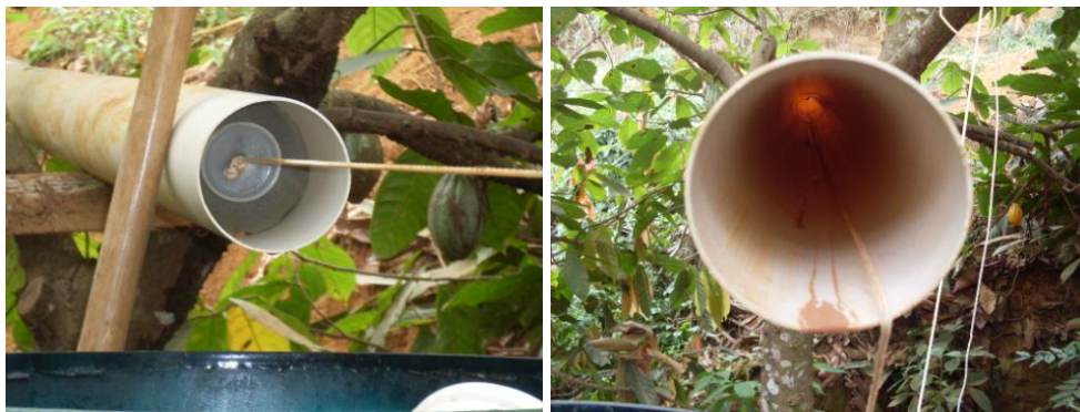
Figura 24 – Limpeza das tubulações com esponjas.
