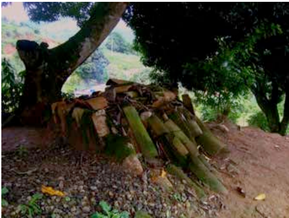
foto 35: parte dos telhados das casas antigas
