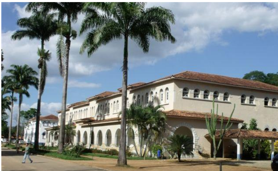
Figura 3 – Instituto Federal do Espírito Santo-Campus Santa Teresa
