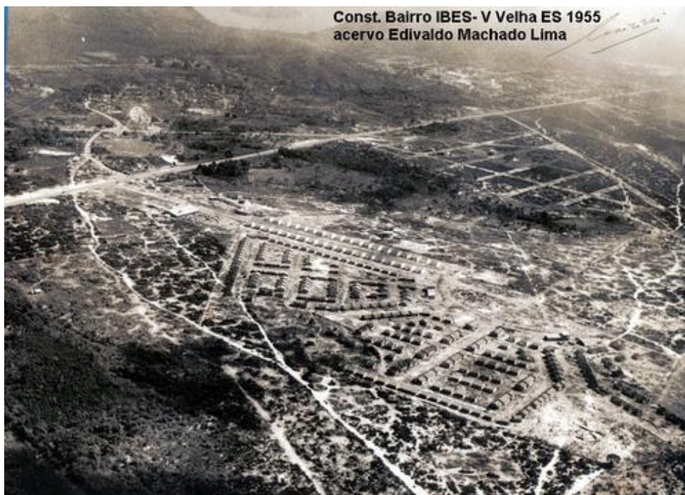
Fig. 59: Construção do Bairro IBES (VIAJE AQUI, 2011, p.01)
