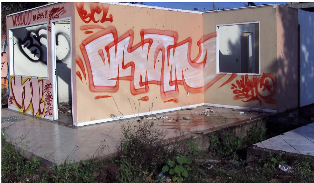
Fig. 94: Ação de grafiteiros em demolição (MICHALOVZKEY, 2013)
