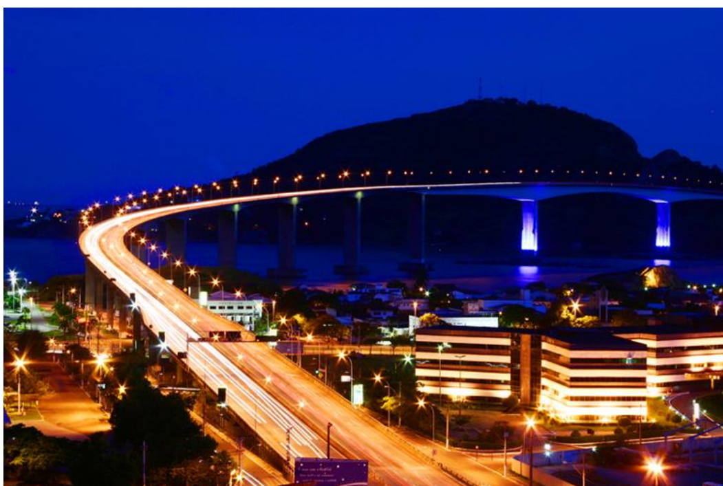
Fig. 61: 3ª ponte (PMVV, 2013)
