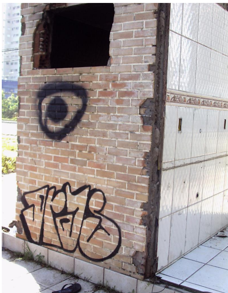
Fig. 95: Ação de grafiteiros em demolição (MICHALOVZKEY, 2013)
