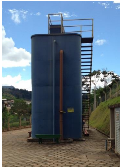
Figura 4.3– Reator UASB da ETE Piaçú.
