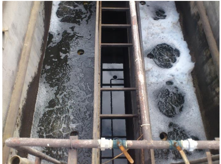
Figura 4.4– Filtros biológicos aerados submersos da ETE Piaçú.
