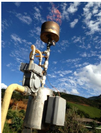
Figura 4.18– Queimador de biogás e adaptações para a coleta.
