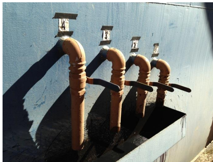
Figura 4.14– Pontos de lodo no reator UASB.
