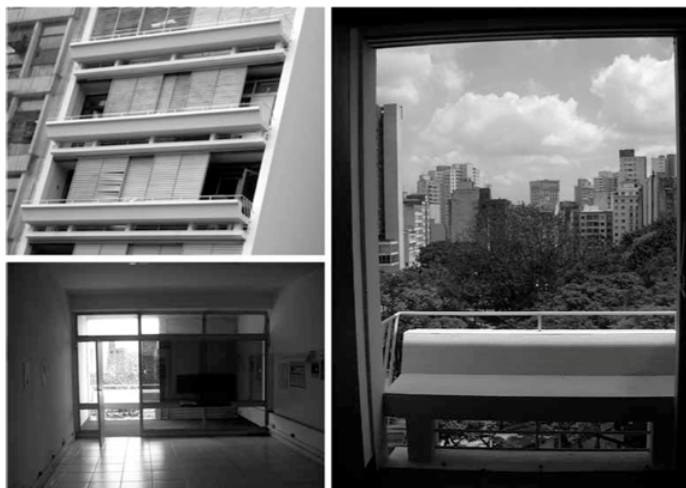
FIGURA 11- Edifício Atlanta – fachada, interior de uma quitinete e detalhe do peitoril da varanda
