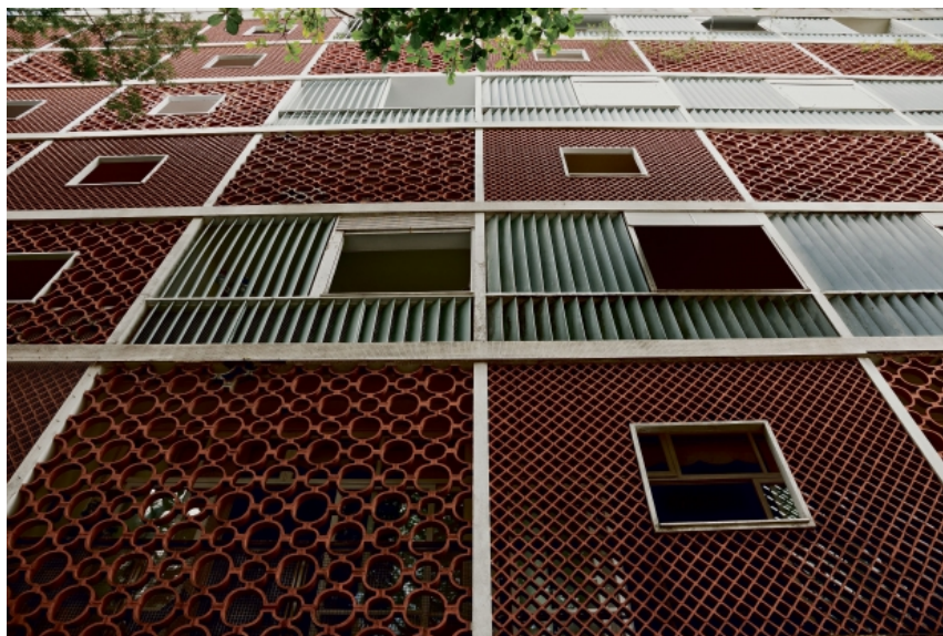
FIGURA 3 - Brise soleils e cobogós da fachada oeste do Edifício Bristol – Parque Guinle
