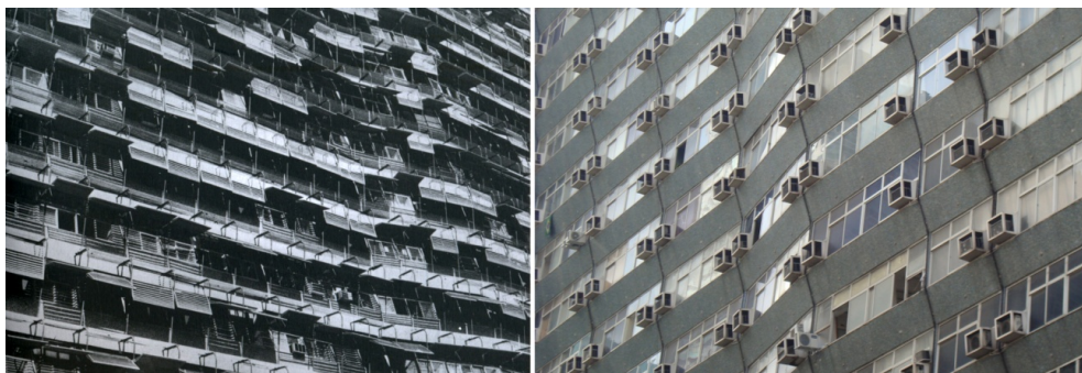
FIGURA 10- Fachada do Edifício Marques do Herval original e após a retirada dos brises.
