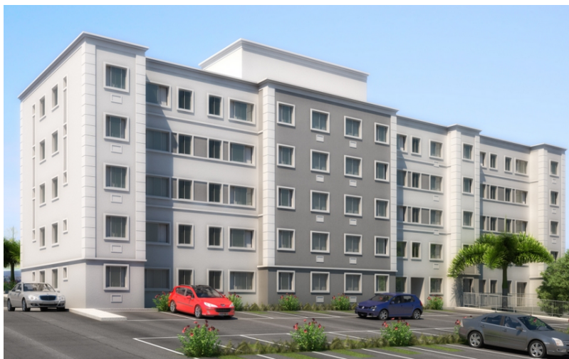
FIGURA 14 – Exemplo comum de utilização de janelas sem proteção solar
