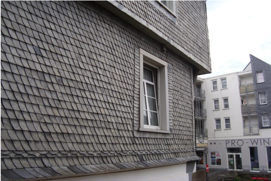
Fotografia 1 - Telhado e fachada de uma casa Alemã com telhas de pedra ardósia. Foto do autor em agosto de 2012.
