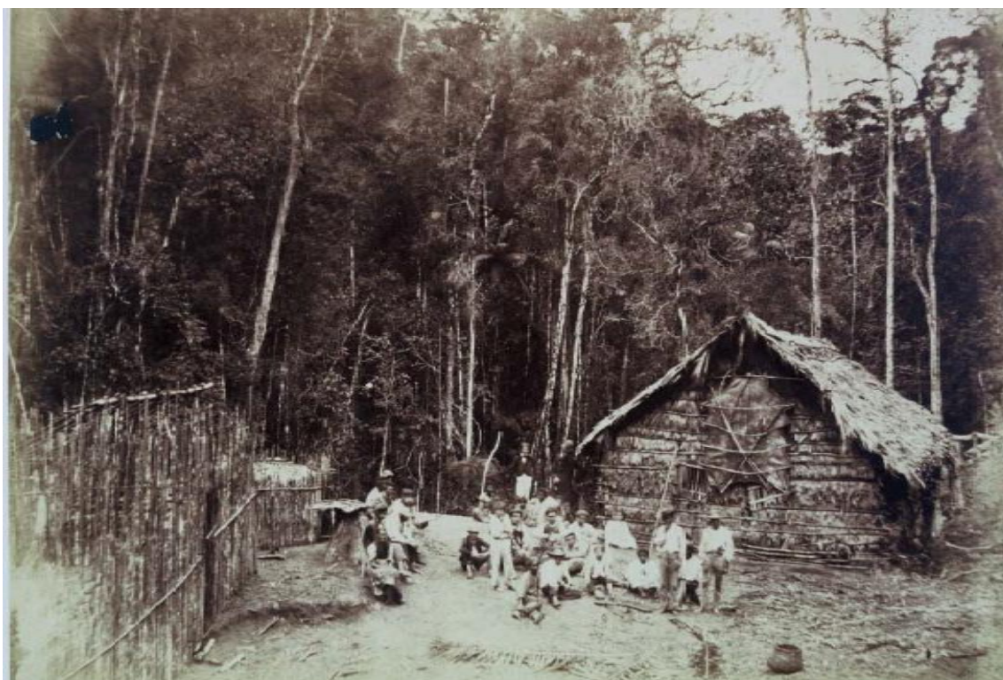
Figura 7 - Casa do engenheiro Amélio Pralon, ex-diretor da Colônia de Santa Leopoldina (1860) Fonte: Rocha, 1960, p.132.
