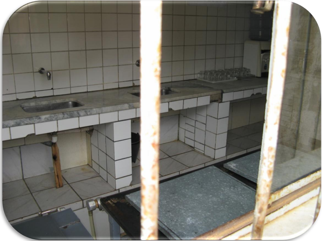
Foto 15: cozinha antes da reforma.
