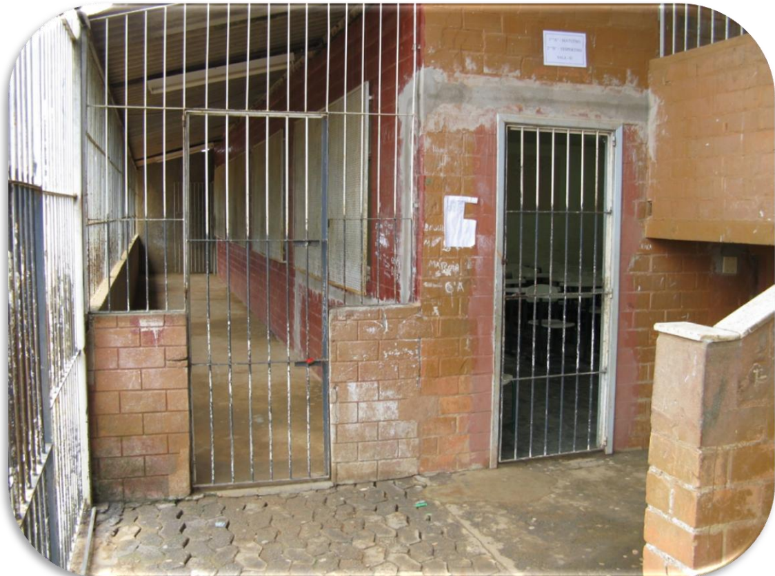
Foto 18: entrada após o portão principal
