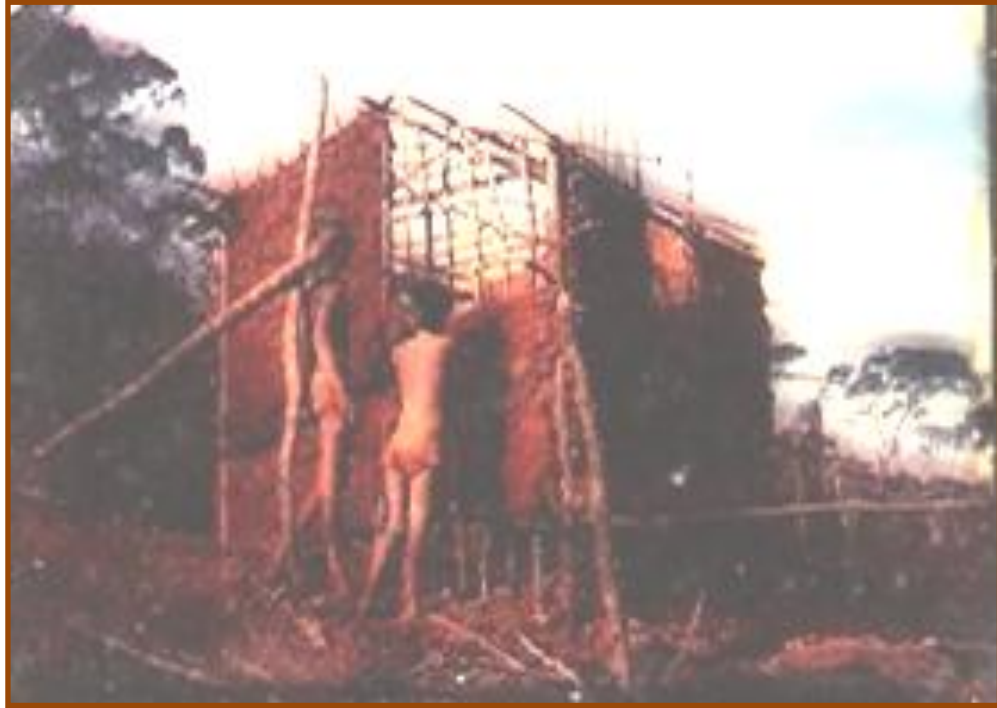
Foto 6 – Construção de casas de estuque baixo grau de consolidação. Fragmentos.
