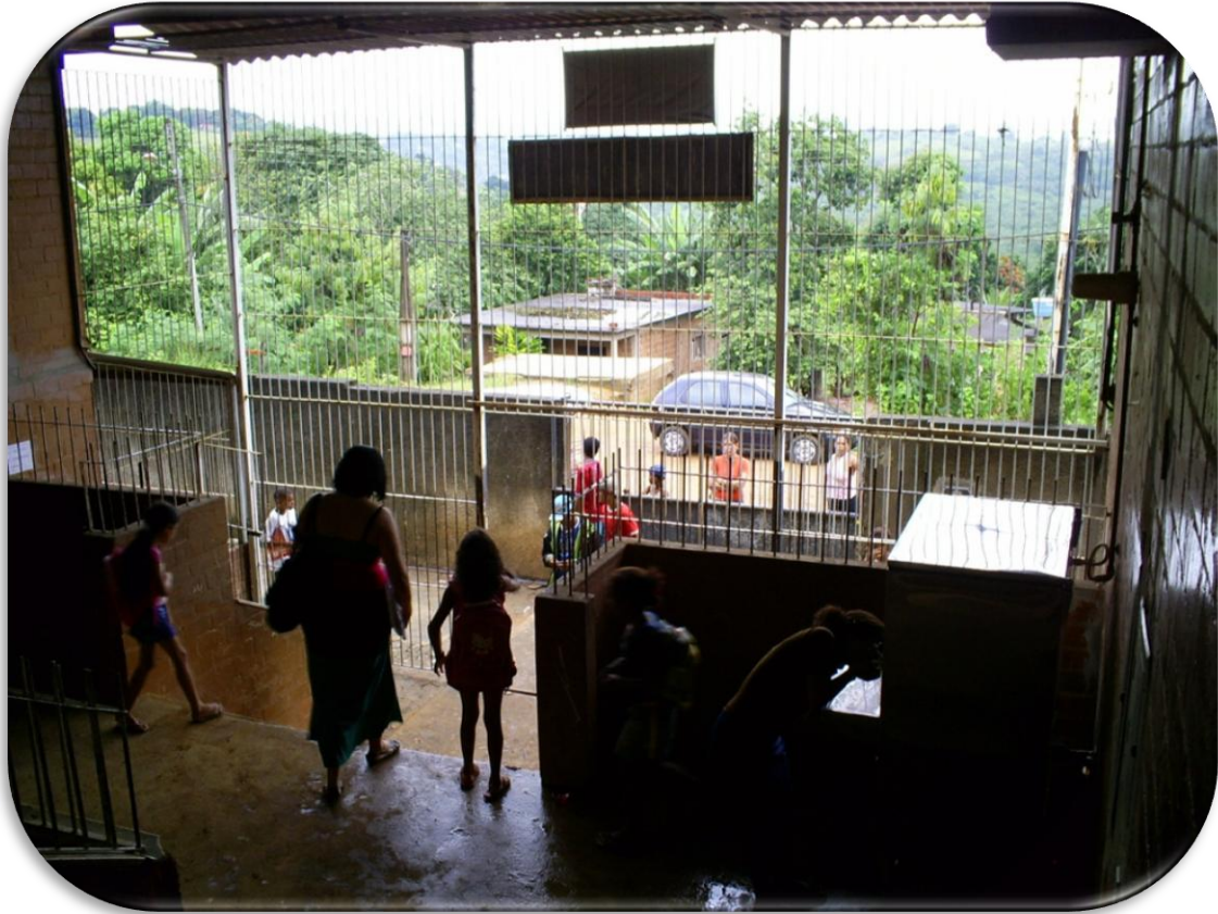
Foto 13 – Prédio antes da reforma: visão do interior para fora
