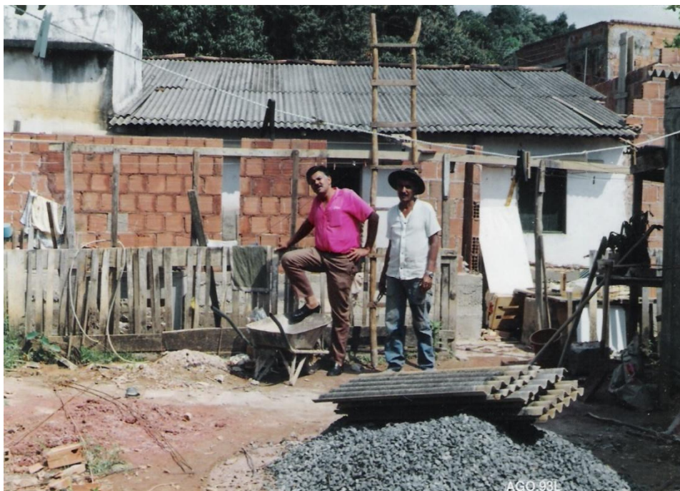
Foto 27 – Construção da residência da Senhora Elza na Rua 23 de agosto.
